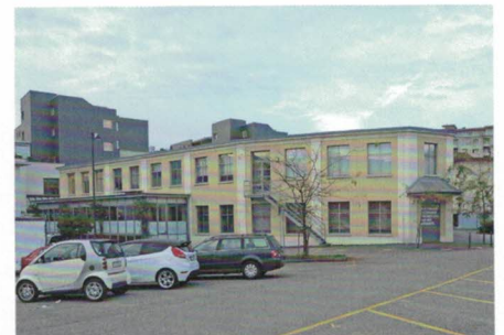
Die Alte Fabrik vor dem Umbau, noch mit den weissen Pilastern. (Foto: Kantonale Denkmalpflege)
